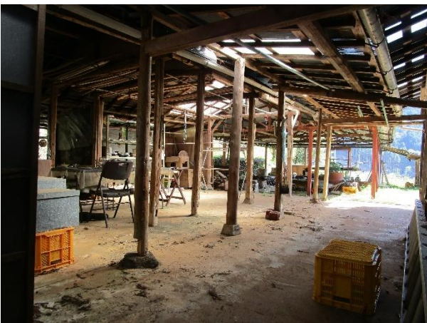
農業資材置場
