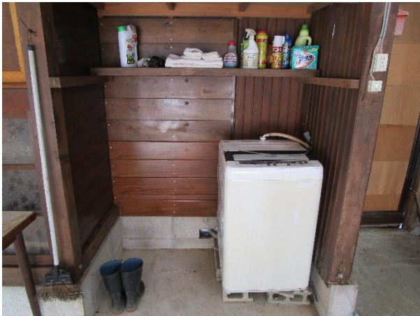
洗濯機置き場（納屋①内）
