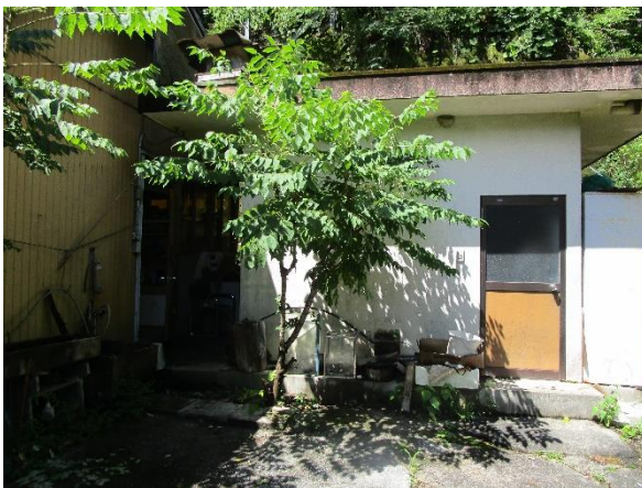
別棟浴室トイレ
