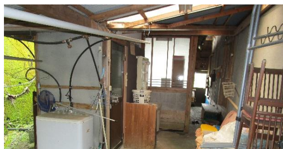
洗濯機置き場・洗面台・お風呂場 全体（外）
