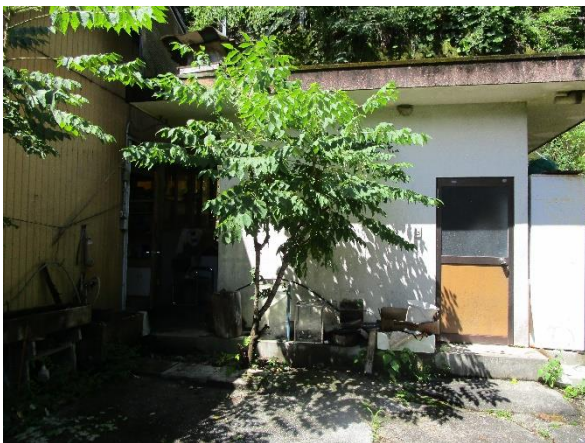
別棟浴室トイレ
