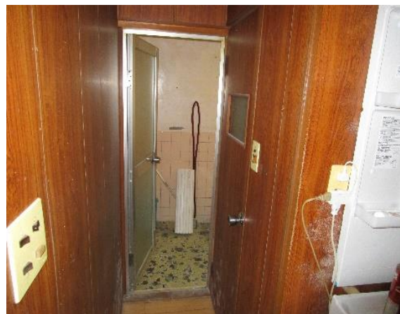
お風呂・トイレ入口
