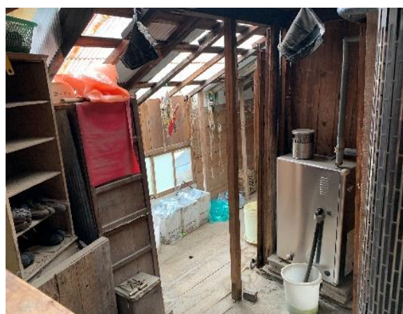
旧トイレ・お風呂場
